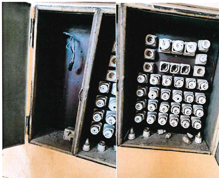
Rysunek 2 - Inwentaryzacja instalacji elektrycznych korytarz parter (przy Sali 46) – rozdzielnica T-9 zasilająca m. in. salę ekonomiczną 43 (obecnie sala komputerowa)
