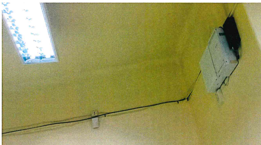
Rysunek 10 - Centrala alarmowa w Sali 88
